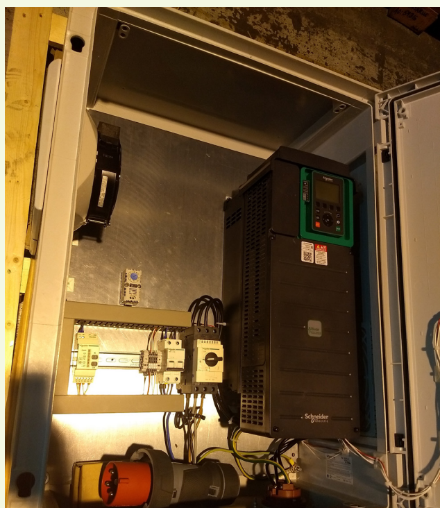
Styringskap med frekvensomformer. Sikker drift og optimal ytnyttelse av pumpe.
